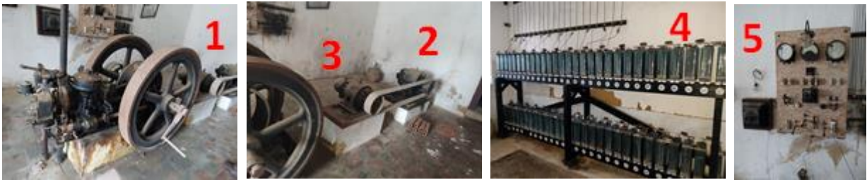
Principais equipamentos da instalação de energia doméstica.
