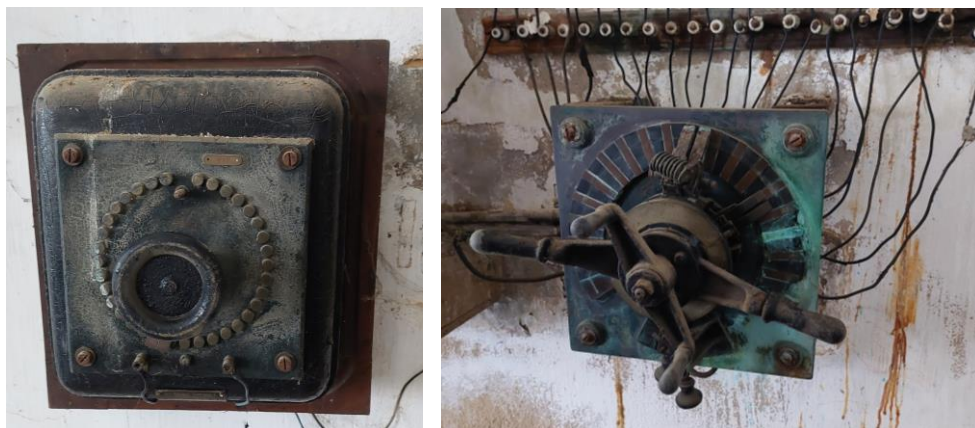
Reóstato de potência e seletor duplo usados no controlo da tensão a aplicar à bateria e a receber desta.
