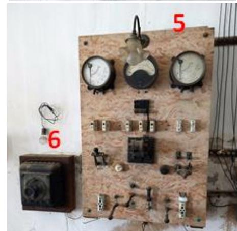
1- Quadro do motor trifásico; 2- Quadro da instalação trifásica; 3- Disjuntor da instalação; 4- Réostato de arranque do motor; 5- Quadro geral de corrente contínua; 6- Réostato do dinamo.
