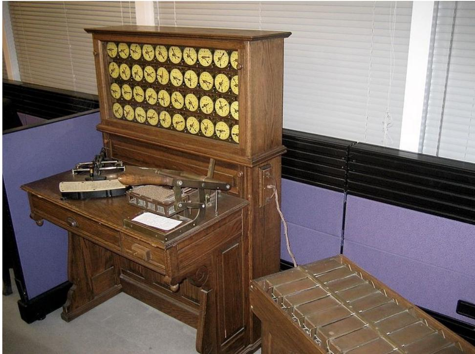
Máquina de Hollerith para perfuração de cartões associada a uma máquina de separação.
