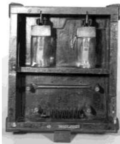
Fig. 2- Contador químico de Edison com 2 células de galvanoplastia.
