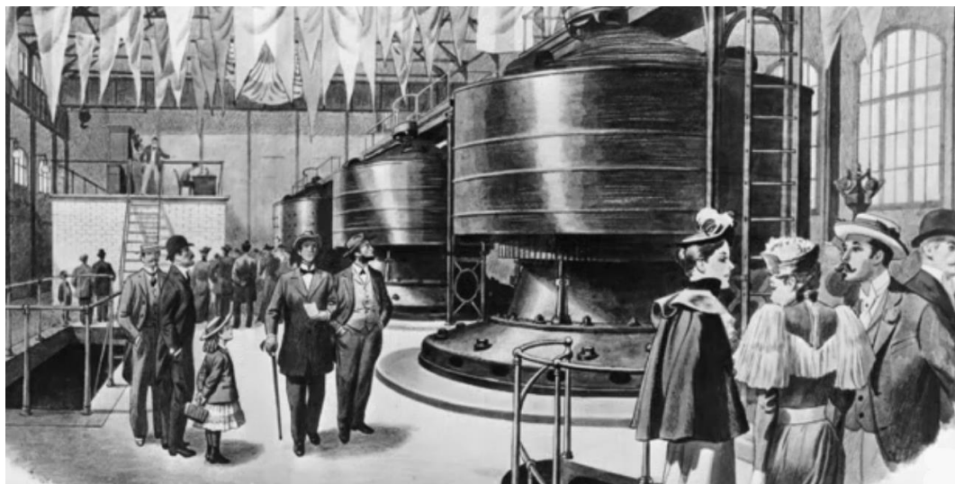
Fig. 16- Central Edward Dean Adams (1836-1931) Niagara Falls, inaugurada em 1895 com alternadores bifásicos Westinghouse.
